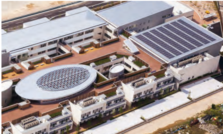
屋上設置されたソーラーパネル（広島特別支援学校）
